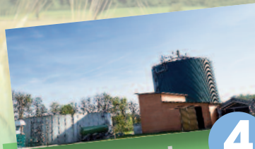
Hof Robrook, Biogasanlage Hollich 59
